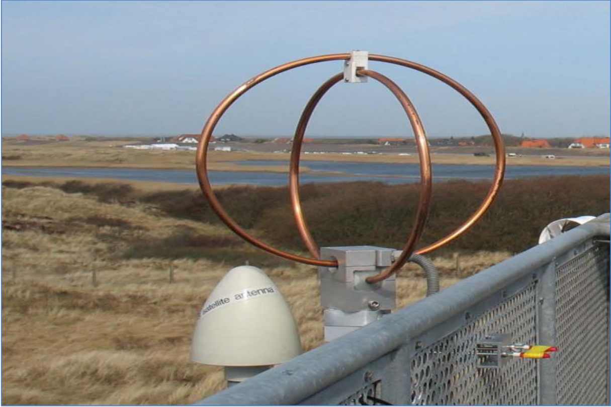
Kurulu Yıldırım Tespit İstasyonu
