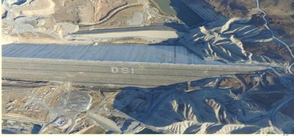
Ilisu Baraj İnşaatı
