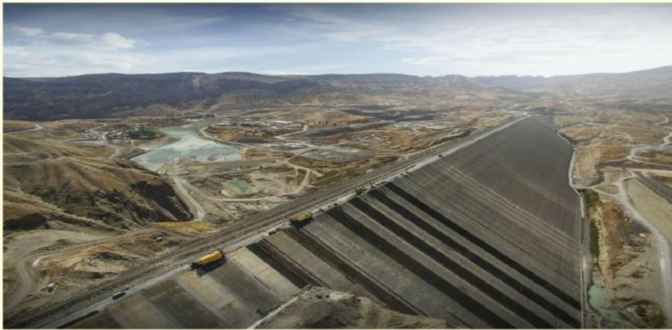
Ilisu Baraj İnşaatı
