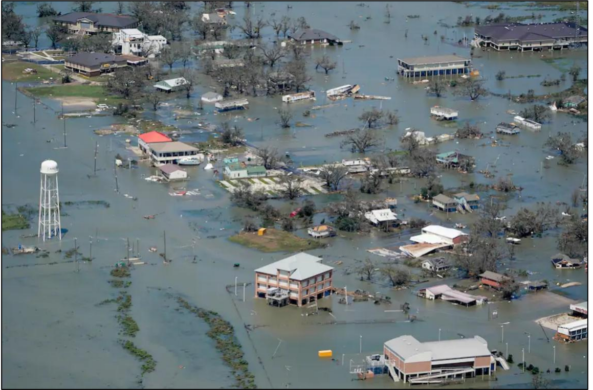
Şekil 35. Laura Kasırgası Sonucunda ABD'nin Louisiana Eyaletinde Oluşan Hasara Ait Bir Görüntü (27 Ağustos 2020) ( https://www.washingtonpost.com/weather/2021/01/08/billion-dollar-disasters-2020/ )
