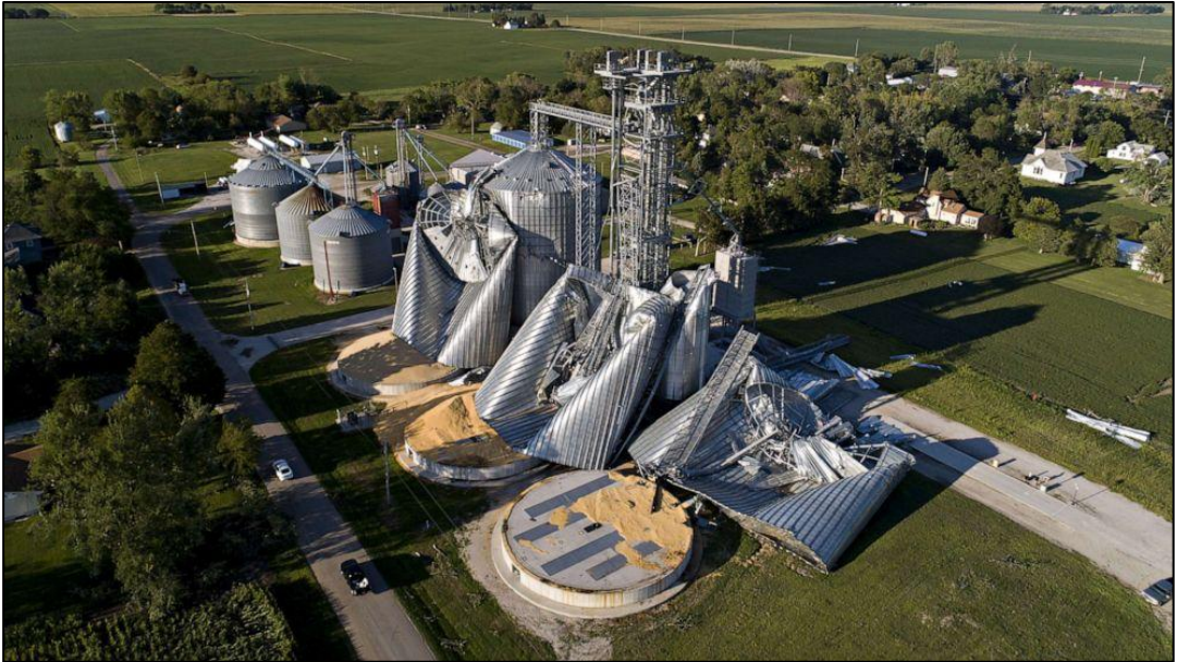
Şekil 37. Luther, Iowa'daki Heartland Co-Op Tahıl Silolarında Fırtına Sonrası Oluşan Hasara Ait Bir Görüntü (11 Ağustos 2020) ( https://abcnews.go.com/US/volunteers-iowa-step-devastating-derecho-storm/story?id=72450668 )
