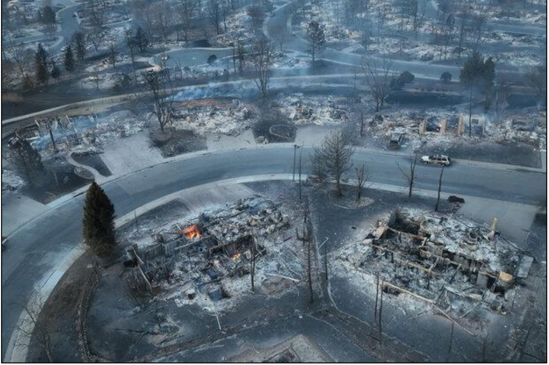
Şekil 42. Louisville, Colorado'da Marshall yangını sonrasında oluşan hasara ait bir görüntü
