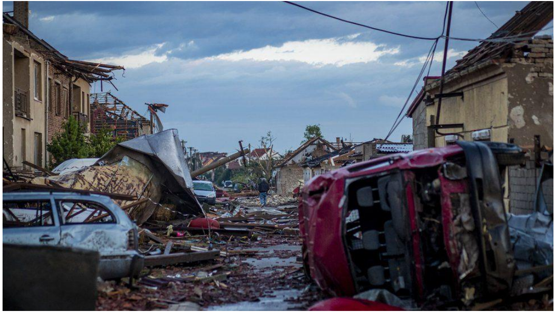
Şekil 80. Tornado sonrası oluşan hasara ait bir görüntü
