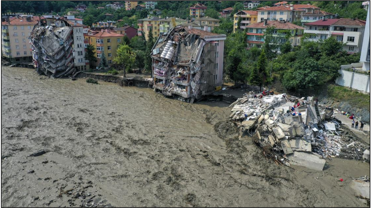
Şekil 75. Kastamonu'nun Bozkurt ilçesinde taşkın esnasında çöken konutlara ait bir görüntü.
