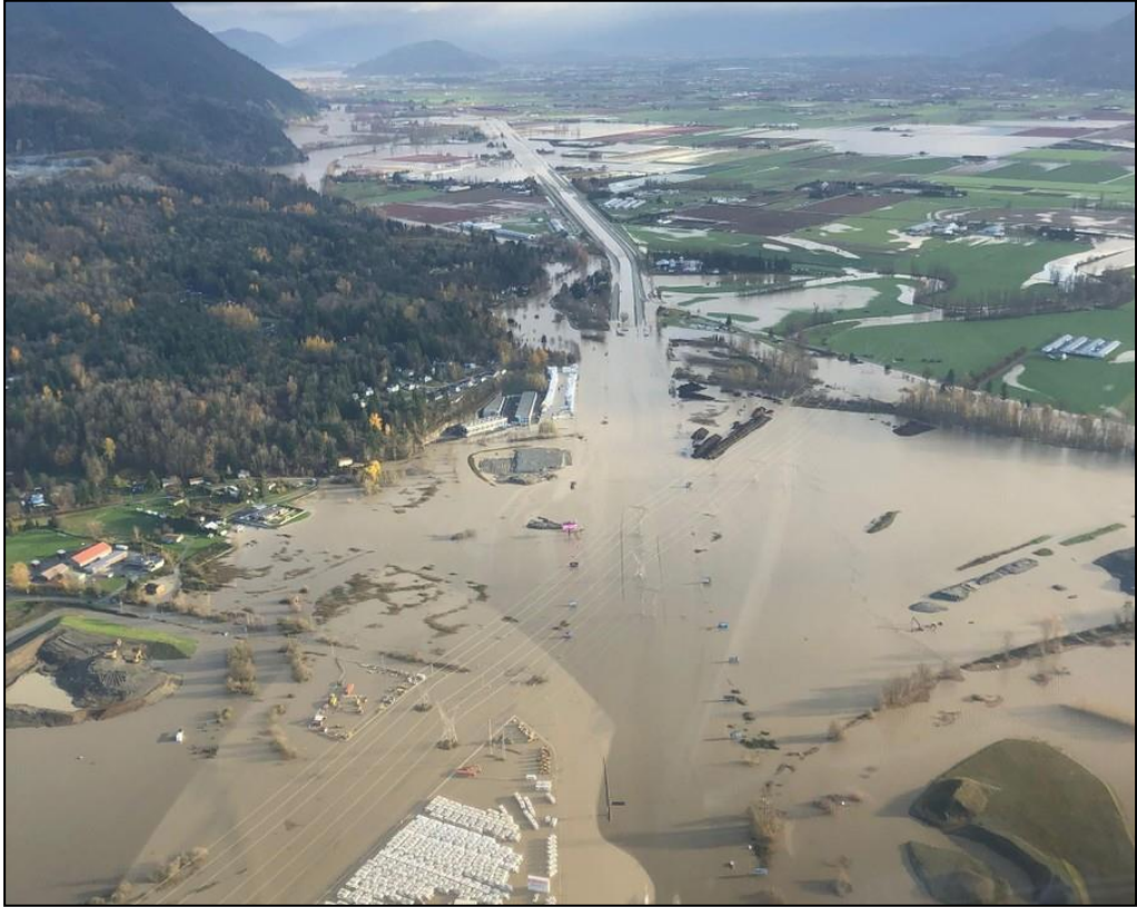
Şekil 48. Kanada'nın British Columbia eyaleti, Abbotsford yakınlarında Trans-Canada Otoyolundaki sel hasarına ait bir görüntü (16 Kasım 2021)
