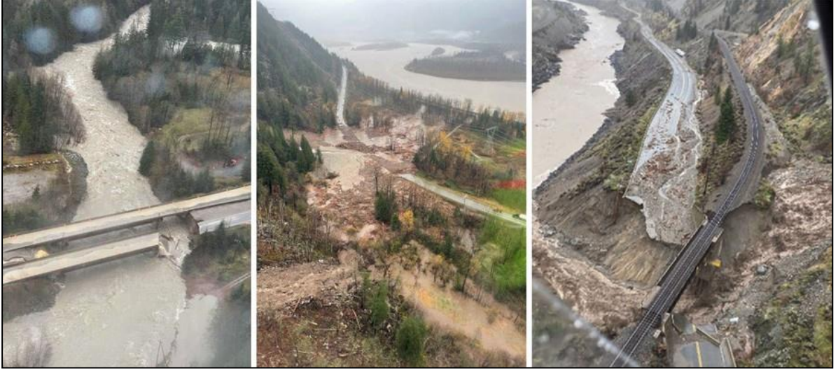
Şekil 47. Sel zararlarını tespit etmek için havadan alınan görüntüler. Coquihalla Otoyolu üzerinde yıpranmış bir köprü, Seabird Adası (ortada) yakınlarında hasarlı yollar ve Lytton, British Columbia yakınlarında selden zarar görmüş bir karayolu ve demiryolu (15 Kasım 2021)
