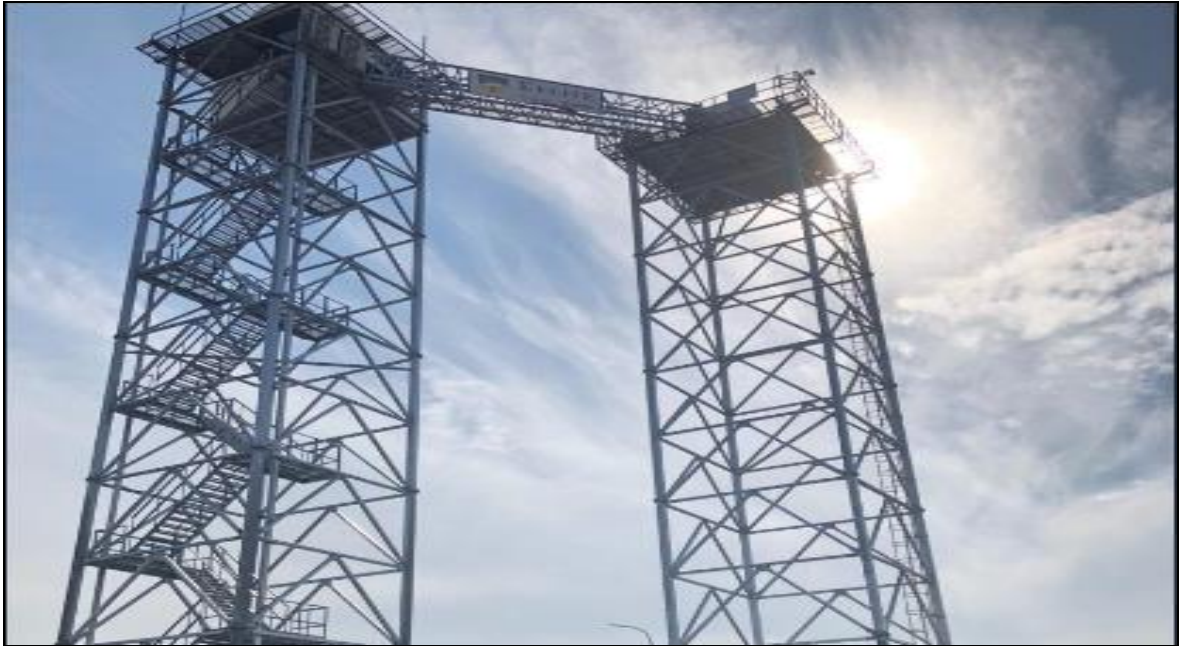
Şekil 8: Alçak Seviye Rüzgâr Kırılımı Uyarı Sistemi - Low Level Wind Shear Alert System (LLWAS)
